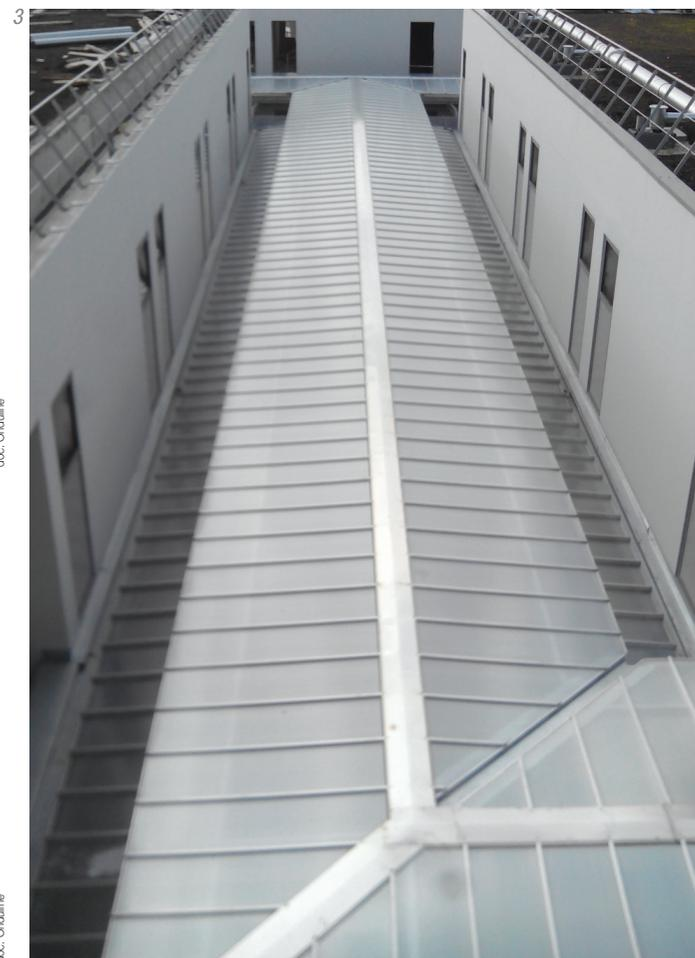
Exemples de réalisation d'Onduclair® PCMW Panel en bardage (1 et 2) et de couverture en Onduclair® Connect (3).
