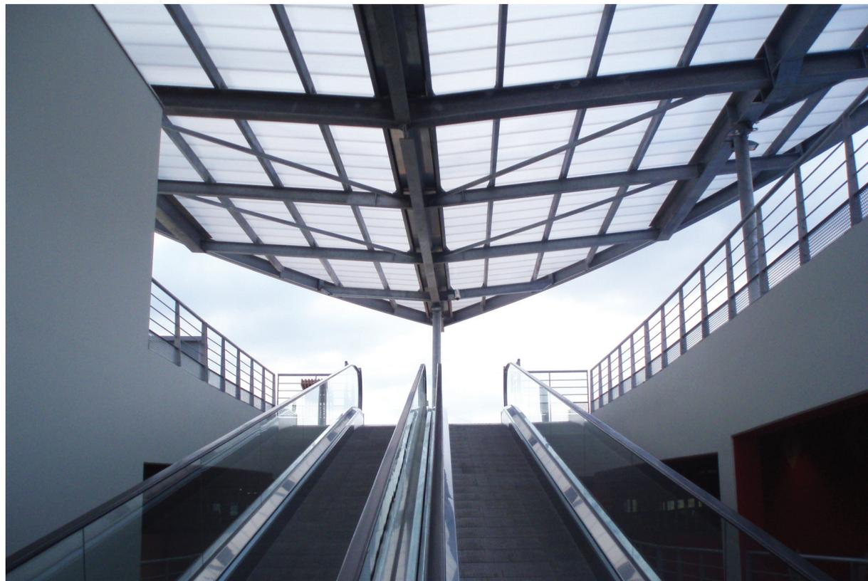
Réalisation d'une couverture transparente en Onduclair® PCMW Connect.
